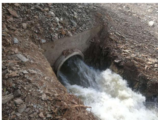
生态放流管安装现状
