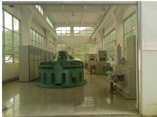
电站厂房内现状
