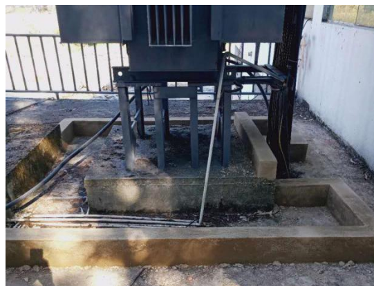
变压器贮油坑现状
