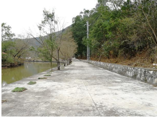
进场道路植被恢复情况
