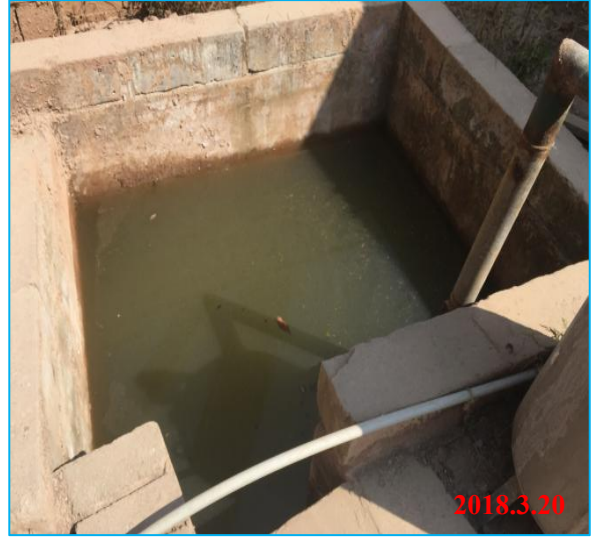
4万t/a工业级磷酸一铵装置雨水收集池
