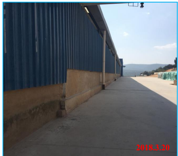
项目西侧雨水管网
